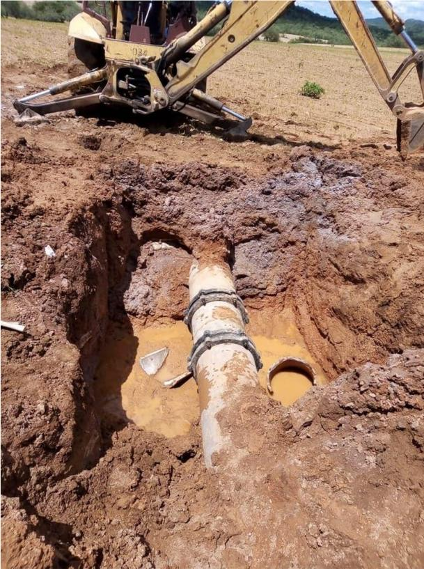
Rehabilitación de **184 mts** lineales tubería de drenaje en el tramo del puente de la trilla al malecón en la c. arroyo seco, barrio del cuero.
