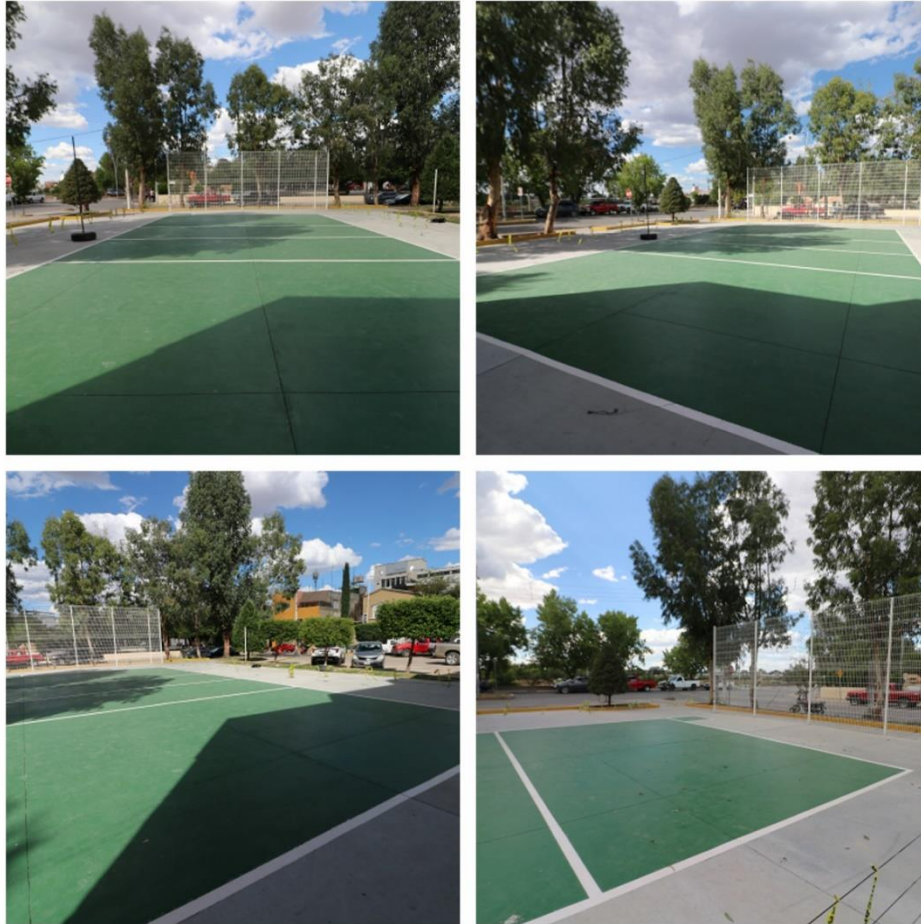
Rehabilitación de cancha de Cachibol
